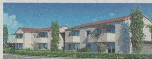
Die GWS baut in Leibnitz 30 Wohnungen
