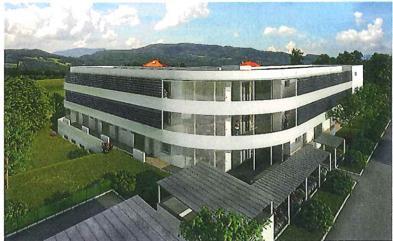
In Gleisdorf entstehen 24 geförderte und freifinanzierte Eigentumswohnungen. Foto: GWS
